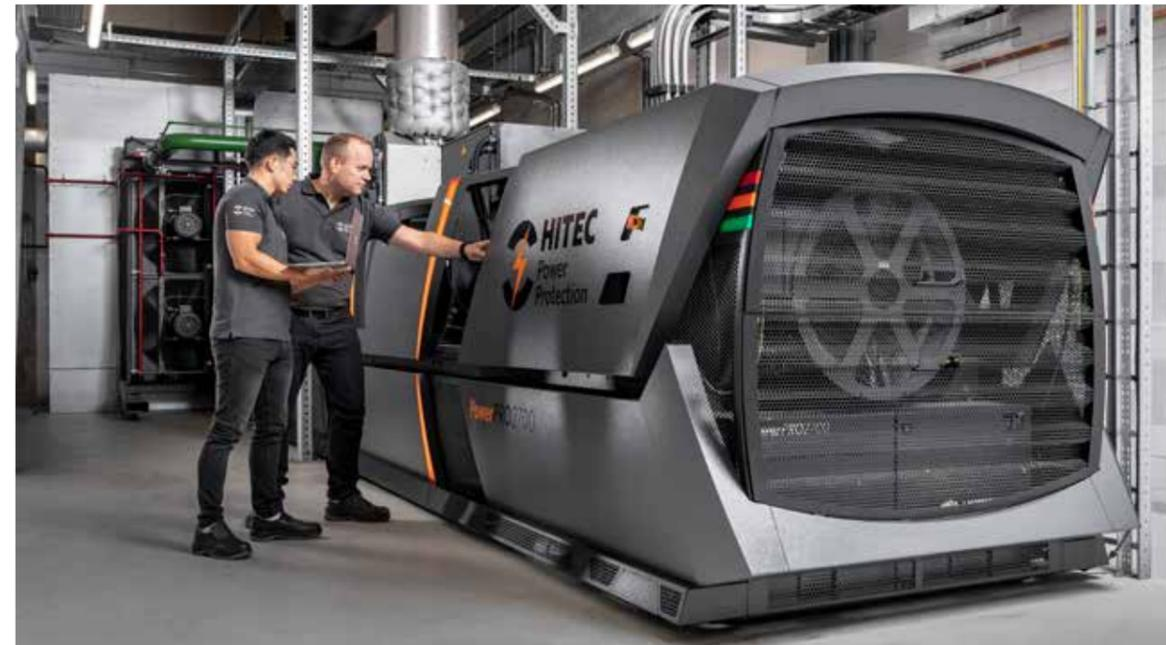
El exclusivo concepto de línea interactiva de un SAI de HITEC ofrece beneficios significativos. El SAI no realiza la doble conversión de energía que un SAI de batería debe ejecutar tan pronto como la energía de la red pública se degrada o cae fuera de los límites especificados. No se utilizan componentes electrónicos de potencia dentro del sistema HITEC; en lugar de eso, el generador síncrono incorporado se utiliza para alimentar la carga.
